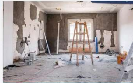
ترميم المنازل للمستفيدين
